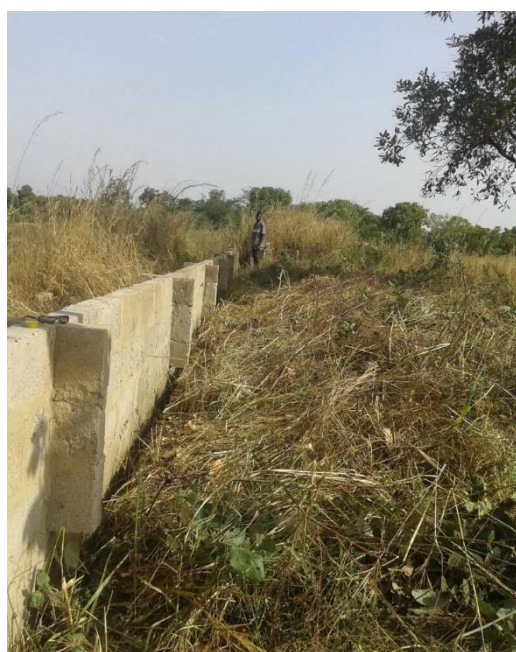
Il·lustració 10 Construcció del mur de pedra per delimitar la finca de CEHDA
