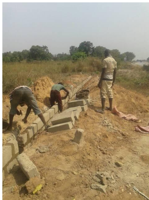
Il·lustració 12 Construcció del mur de pedra
