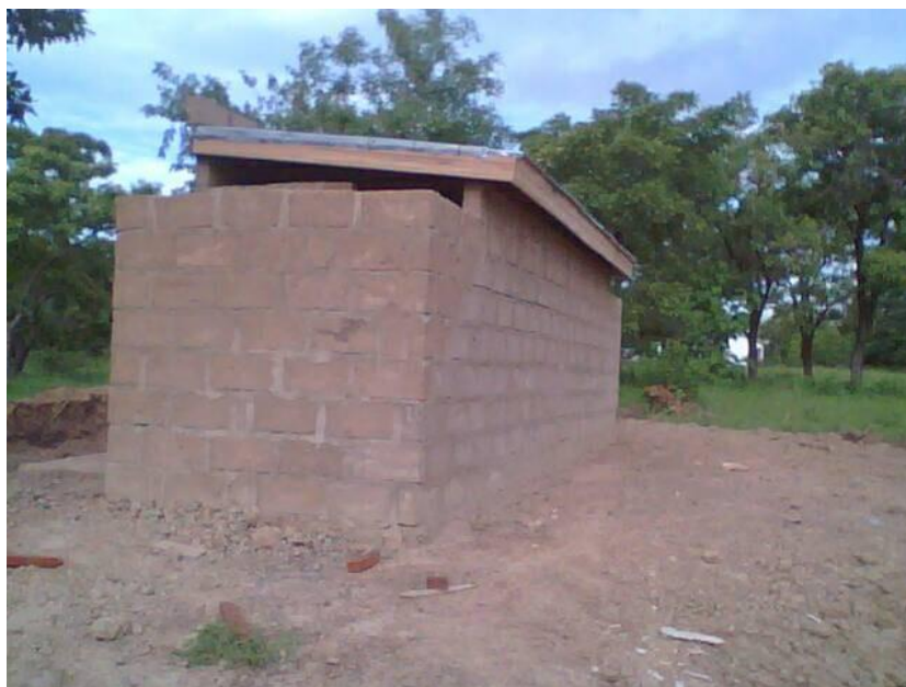
Il·lustració 9 Les latrines casi acabades
